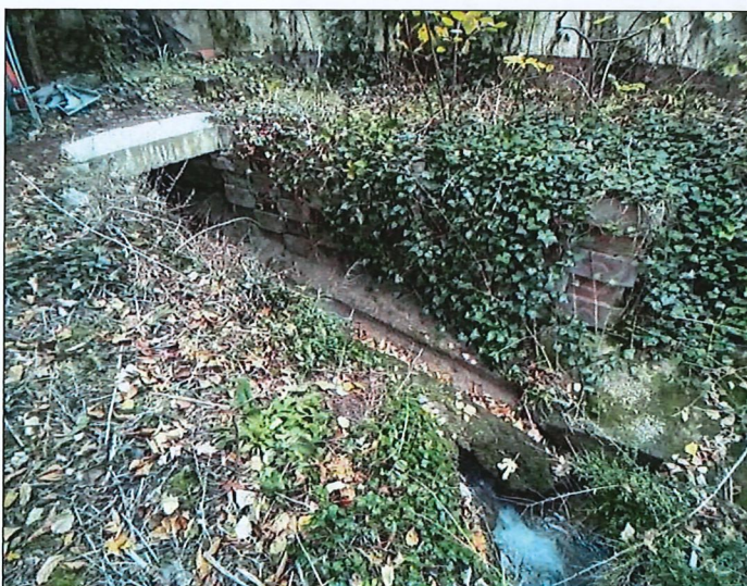
Photos 2 et 3 – Parcelle n°115 / Cunette en béton dégradée
