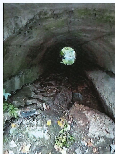
Photos 2 et 3 – Parcelle n°115 / Cunette en béton dégradée
