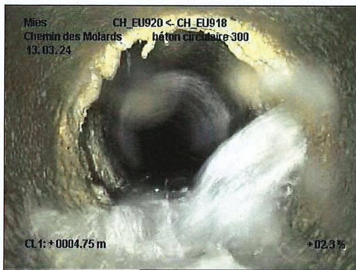
**Photo 1 : collecteur d'eaux usées situé sous le cours d'eau du Torry montrant une infiltration importante d'eaux claires parasites.**
