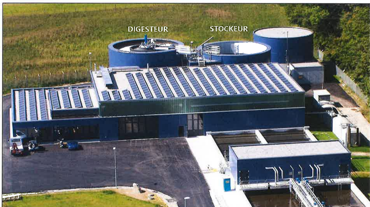
Figure 1 : vue sur le digesteur et le stockeur
