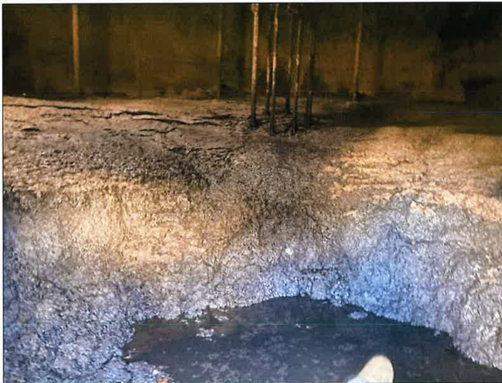
Figure 2 : Sables et limons dans un digesteur.
