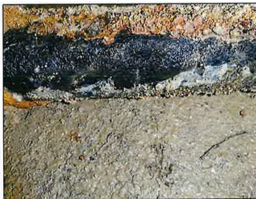
Etat de la conduite : corrosion externe de la fonte
